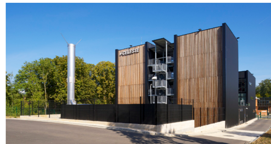
Datacenter vertical de l'entreprise Celeste en Seine-et-Marne
