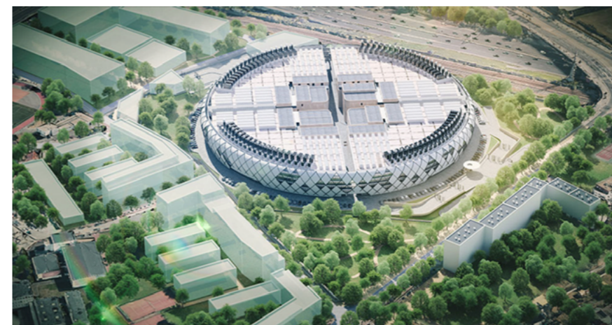
Datacenter Interxion à la Courneuve (93)
